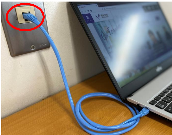
(図 1-1) LAN ケーブルの接続
